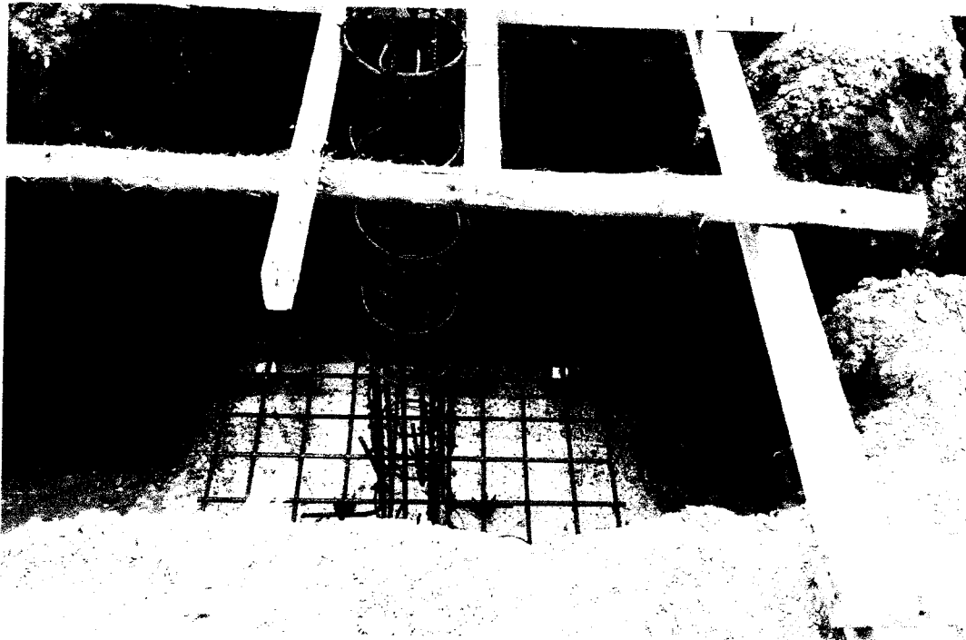
Foto N° 11: Acero Corrugado en Zapata – Área Frio
