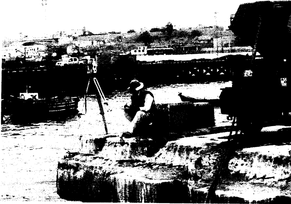
Foto N° 01: Trazo y replanteo de la obra.
