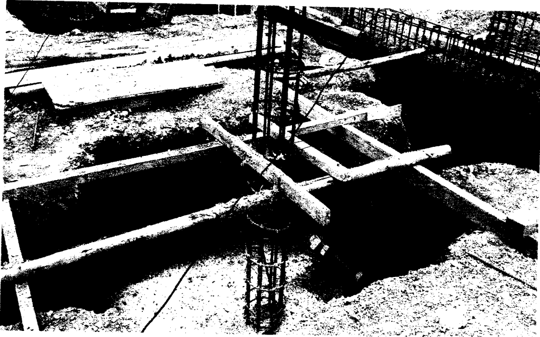
Foto N° 10: Concreto en Solado Área de Frio
