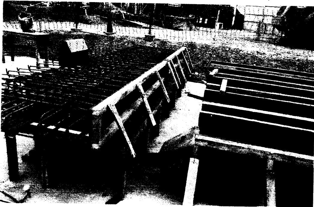
Foto N° 05: Encofrado de Losas Nervadas para cabezo en el muelle.
