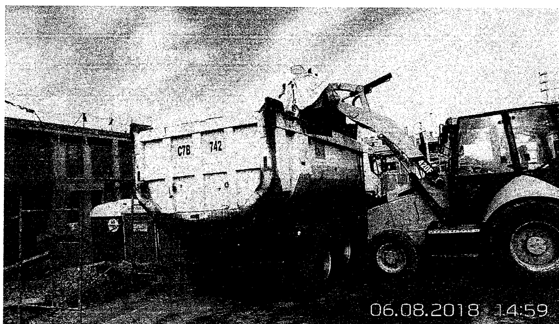
CARGUÍO DE ESCOMBROS Y ELIMINACIÓN DE SOLIDOS
